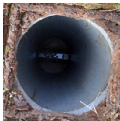
Figure 4 Tabouret niveau normal : bouchage de la canalisation privée - travaux à la charge du particulier
